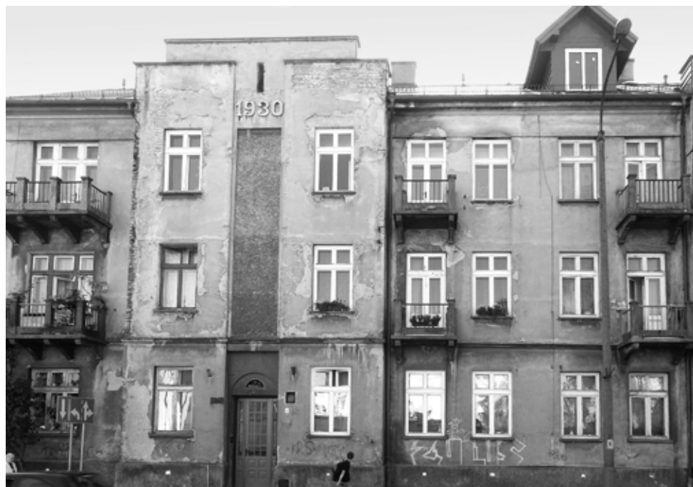
15. Budynek w Białymstoku przy ul. Ogrodowej 2 - siedziba radzieckich służb. Tutaj przesłuchiwano C. Hake w 1944 r.
