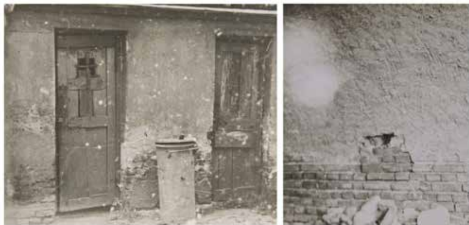
16. Parterowe komórki na tyłach budynku przy ul. Ogrodowej 2. Miejsce uwięzienia C. Hake oraz otwór, który wykonał i uciekł.
